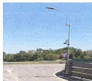
SS.45- via Duomo- Settima: Palo con n° 1 telecamera di lettura targhe
